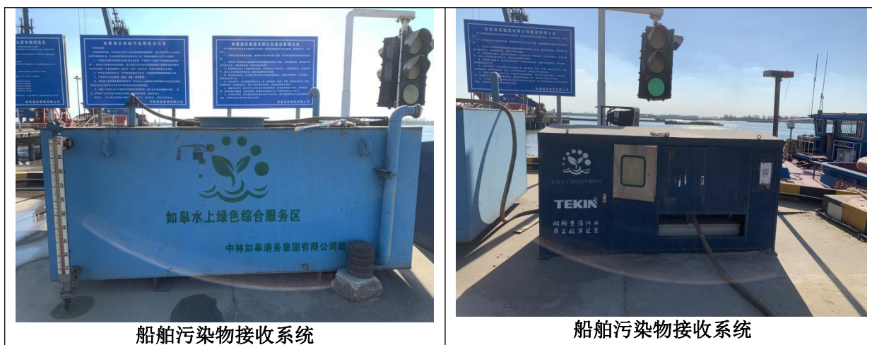
图 3.8-4 港区现有污水处理站、雨水收集措施
